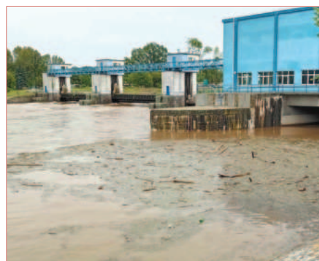
Labe u elektrárny v Hradištku
